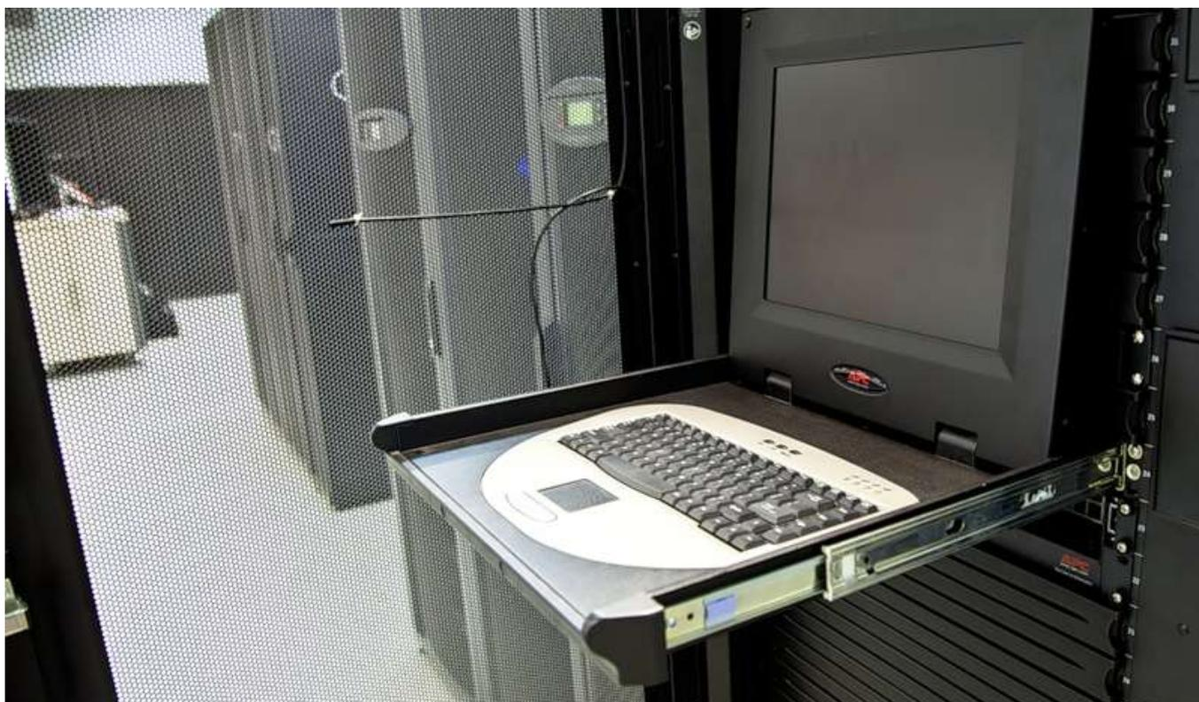
Чудо-аппарат или «ноутбук» размера 1U (почти ноутбук – состоит из клавиатуры, touch-пада и монитора). В сложенном состоянии полностью убирается в стойку, в открытом – может использоваться в качестве консоли управления.
