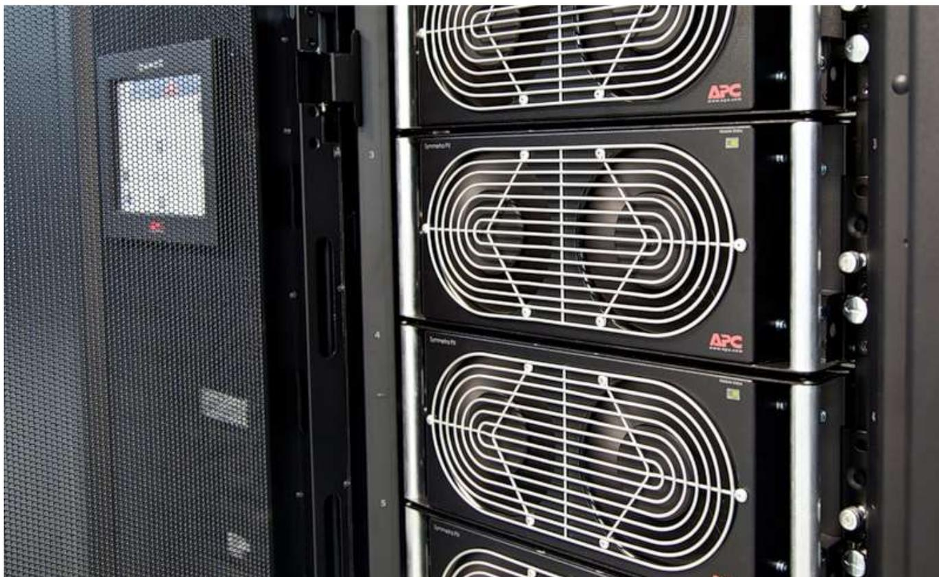
Силовые модули. Здесь также поддерживается «горячая» замена, правда для осуществления таковой желательно привлечь пару сильных инженеров;-) – вес модуля составляет чуть более 40 килограмм. Хотя, признаться, процесс замены модуля или добавления нового для увеличения мощности ИБП, проводится очень просто.
