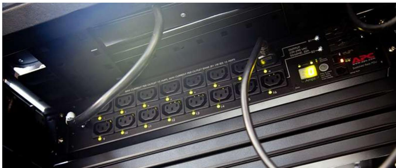
Стоечный распределитель питания, серверный вариант «тройника». Подключается к сети Ethernet и поддерживает возможность удаленного управления питанием каждой из розеток.
