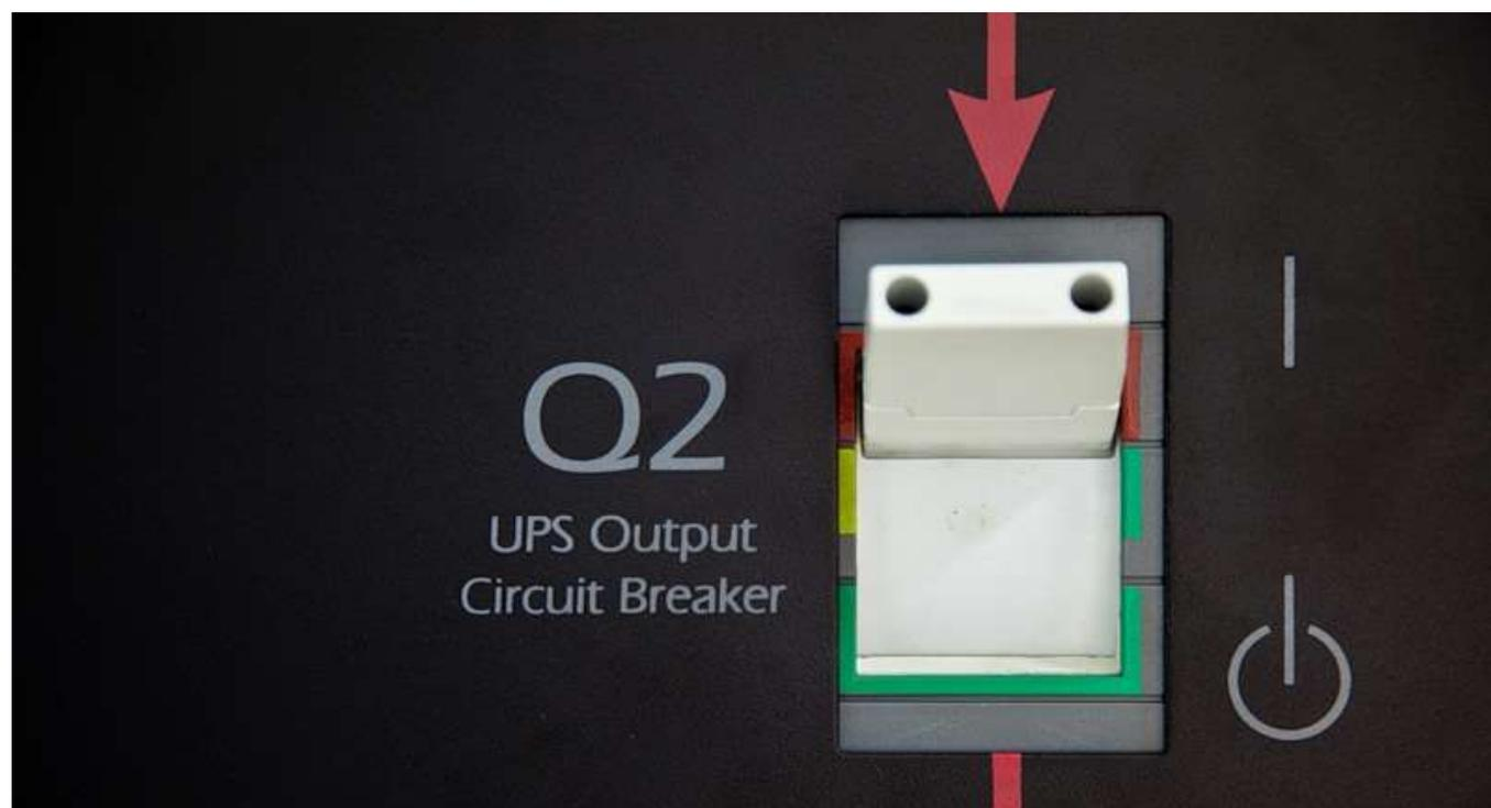
Большие переключатели в блоке управления питанием. Здесь можно переключить ИБП в байпасный режим: когда он просто пропускает входное напряжение на выход ничего с ним не делая. В таком режиме можно проводить серьезное обслуживание ИБП.
