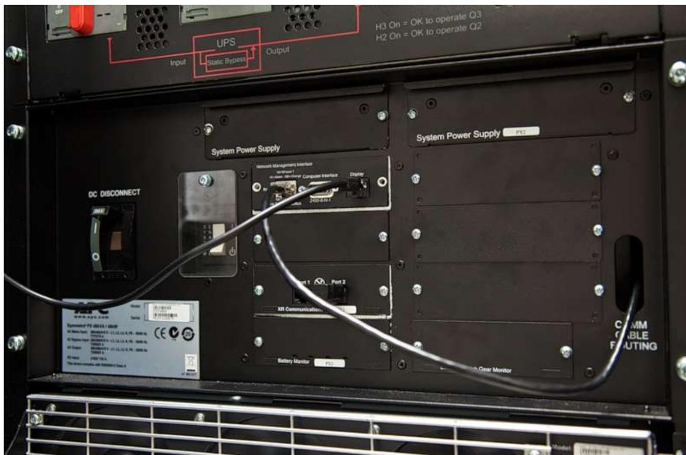
С помощью небольшого модуля (в центре кадра) ИБП подключается к локальной сети для удаленного управления и мониторинга. Второй кабель ведет как раз к консоли.
