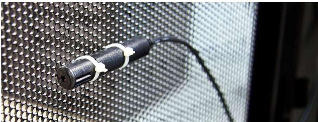
Датчик температуры и влажности, установленный на двери серверной стойки.
