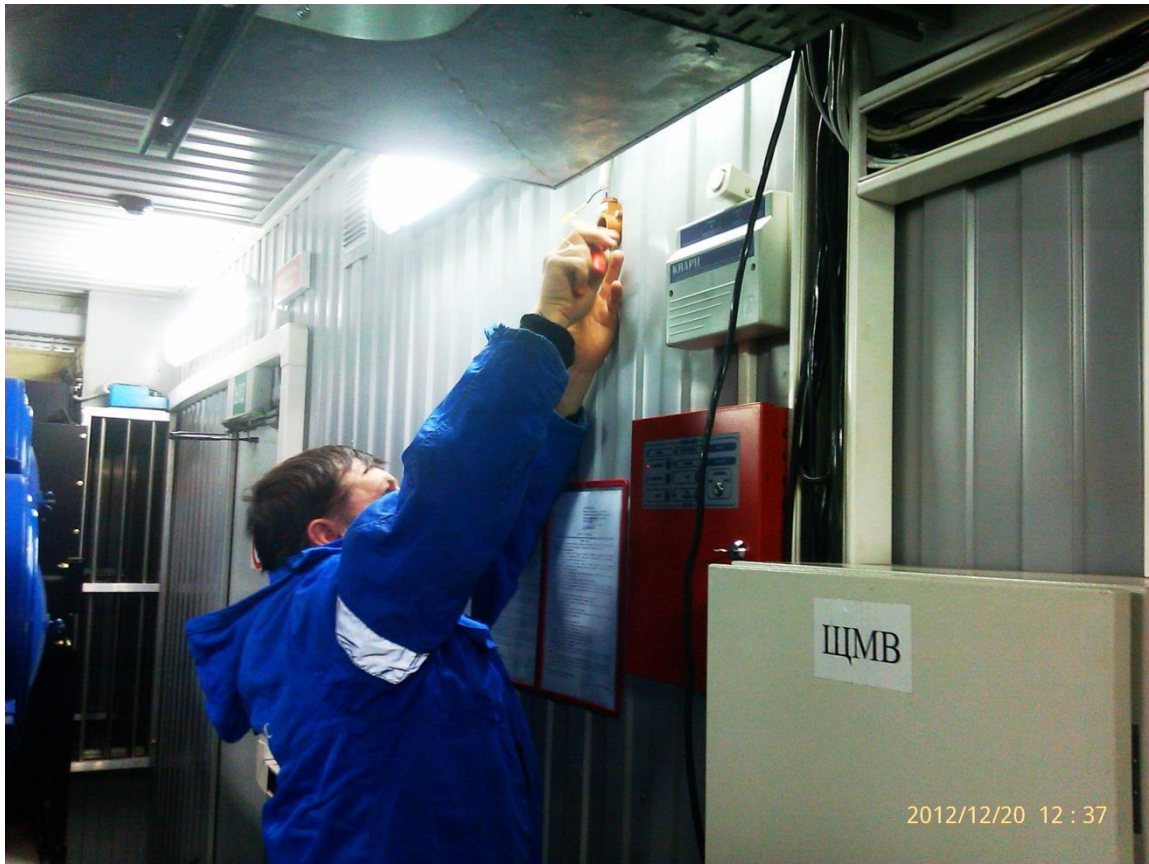
Рис. 11. Перенос датчика – пусконаладочные работы.
