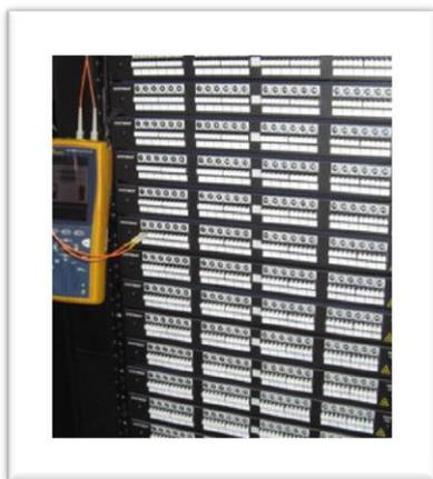
Это решение практически копирует решение с применением сварочного оборудования ВОЛС, за исключением самого процесса сварки волокон. Вместо сварки волокон монтируется механический сплайс, задача которого - с максимальной возможной точностью зафиксировать волокна пигтейла и кабеля относительно друг друга на весь срок службы СКС ЦОД.
