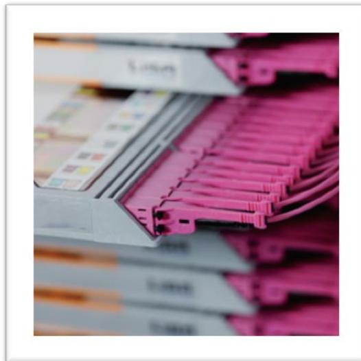
монтируется **Фэнаут-сборка (гидра)**, что позволяет существенно упорядочить коммутации в стойке.
